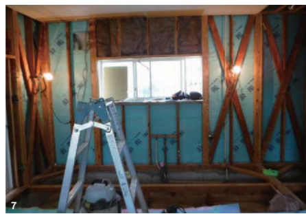
4_リビングから続くデッキは、耐久性のある素材に生まれ変わった。日向ぼっこが心地よい空間 5_新しい化粧台が映える、広々とした洗面脱衣所。風呂場は建具を引き戸に変更し、段差もなくすることで使い勝手が増した 6_朽ちていて、せっかくのスペースが有効活用できていなかった、かつてのデッキ 7_筋交いや補強金物を入れるなど、耐震補強で安心のマイホームに
