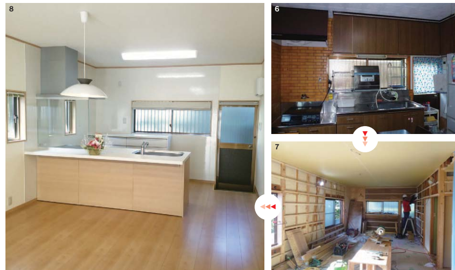
6・7・8_リフォームに合わせて耐震改修も行ったお宅。2間あった間取りを広々としたLDKに変え、キッチン是对面式に。耐震壁の追加や柱や梁の補強、さらに漆喰壁を残しつつ断熱材を加え、安心して家族が回らんでくる空間に
